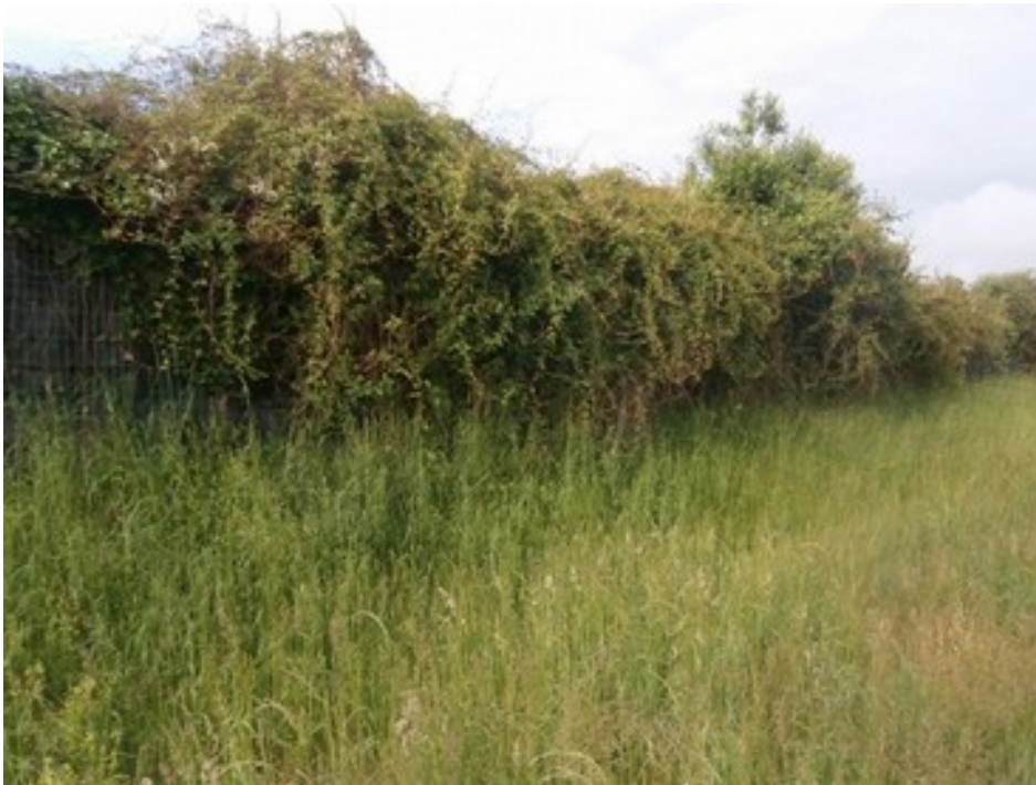
Foto 8: ECOWALL Völkermarkt Blick von Norden nach Südwesten. Detailaufnahme: Dichter Bewuchs
