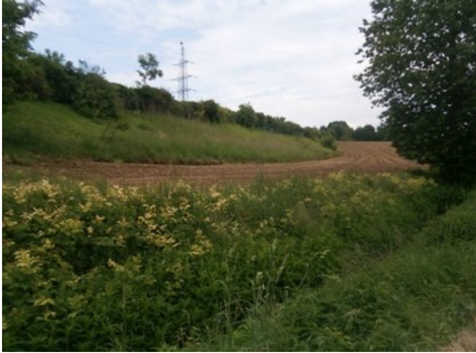
Foto 1: ECOWALL Völkermarkt Blick auf die Südseite. Der ursprünglich vorgesehene Damm wurde abgetragen und auf der verbleibenden Dammkrone das ECOWALL Projekt errichtet. Dadurch wurde der Lärmschutz verbessert und eine Wiese dazugewonnen.
