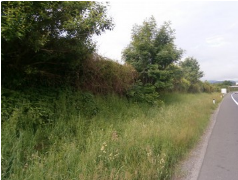
Foto 6: ECOWALL Völkermarkt Blick von Norden nach Südwesten. Detailaufnahme: Dichter Bewuchs
